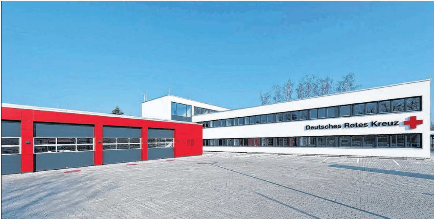
Links befindet sich die Wagenhalle mit den Rettungsfahrzeugen, rechts der Verwaltungstrakt und im hinteren Gebäude ist der Ortsverein Offenburg untergekommen.
